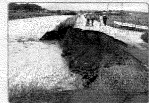
平成22年出水・嘉麻市の堤防のり面の洗堀 (遠賀川河川事務所HPから)
